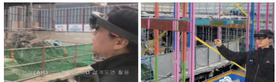
[그림 7] AR을 활용한 시공전 현장 확인(토목현장)
